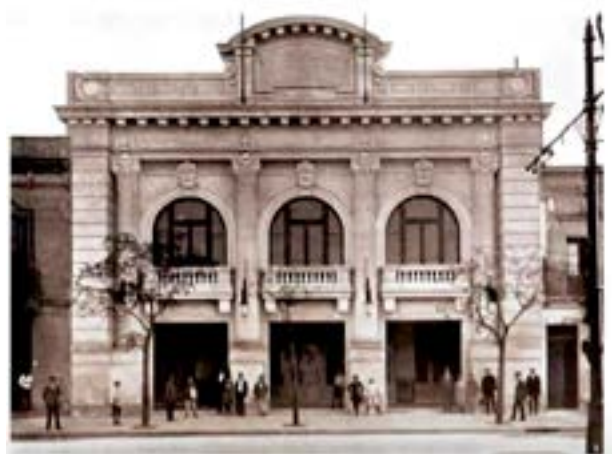
Edificio del primer cine Roca, diseñado por Mario Palanti.
